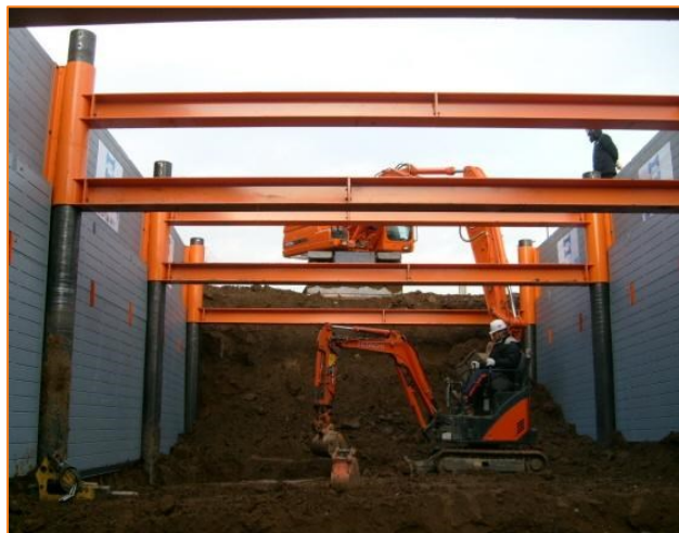
고심도·확폭 굴착이 가능한 Hybrid 흙막이 공법
