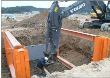
① 가이드포스트 설치
