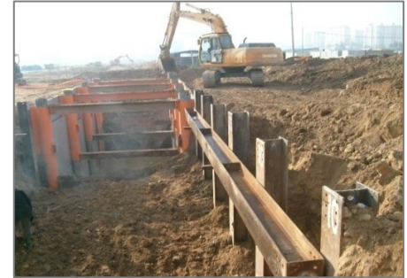
④ H-파일 및 띠장 설치
