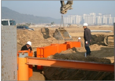
① 천공가이드 설치
