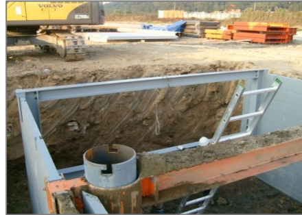
③ 임시 버팀가이드 설치
